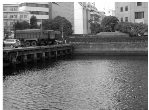
石積みの護岸が残る船溜り
