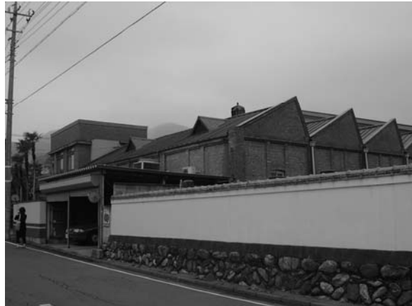
煉瓦のノコギリ屋根工場
