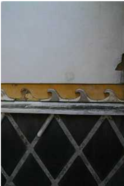
蔵の外壁：足元と上部の間の水切り部分、左官のディテール
